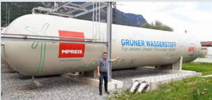
Amir Habibelahian zeigt in Völs den Wasserstofftank der Elektrolyse-Anlage von MPREIS.
