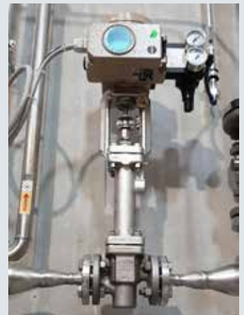
Wasserstoffregelung durch SAMSON-Hubventil Typ 3241-7 mit Balgabdichtung.
